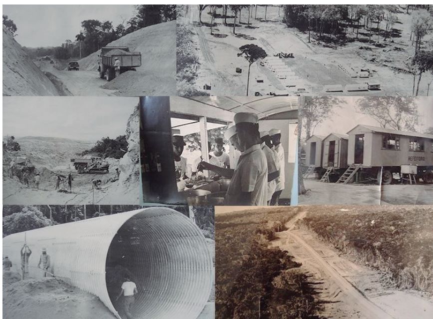
Foto 1 - Construção da Br-163 – Trecho Cuiabá (MT)-Santarém (PA)
