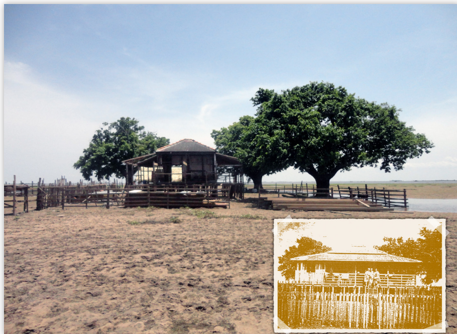
Figura 2. Casa-sede da Fazenda Boa Esperança na Ilha dos Patos, na década de 1930. Fotografia cedida por Socorro Braun (2008). Em agosto de 2014, os herdeiros dos Soares de Aquino estavam construindo uma nova casa no mesmo lugar onde a casa antiga fora destruída por uma enchente no teso da Ilha dos Patos. Fotografia: Ricardo Folhes.
