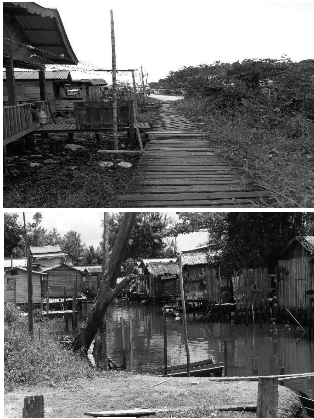
Fotografia 2 - Zonas periféricas carentes de infraestrutura e saneamento no município de Breves (PA)
