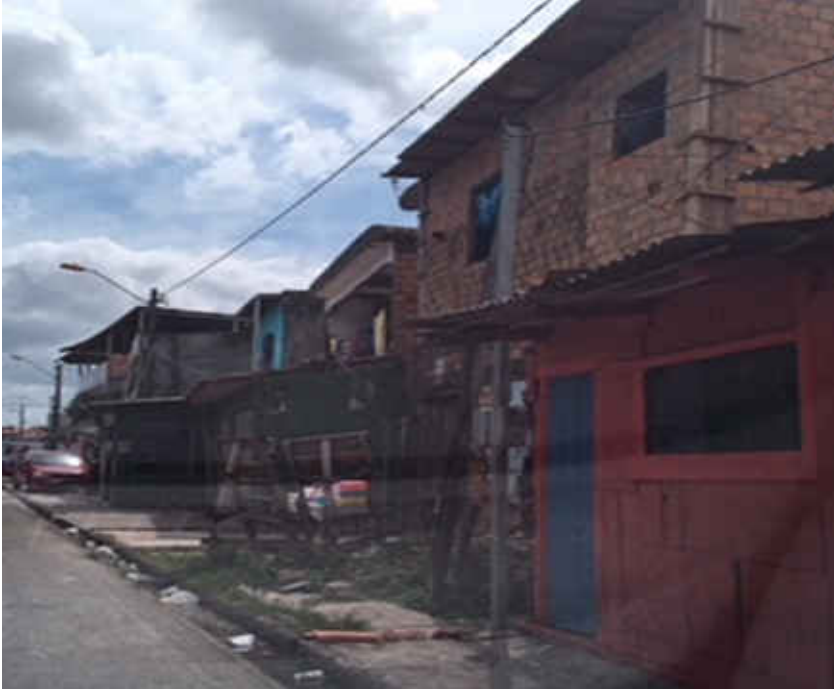
Foto 23 – Um quarteirão de casas às margens do Canal São Joaquim.
