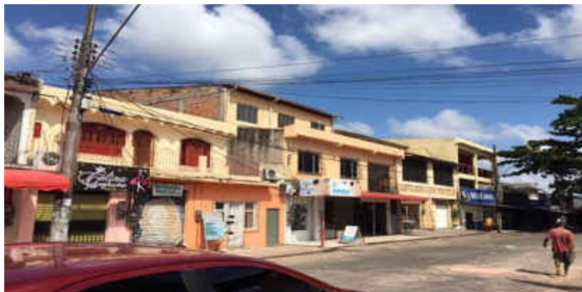
Foto 12 – Rua asfaltada do Conjunto Providência com casas COHAB já remodeladas e com dois pavimentos (janeiro de 2018).
