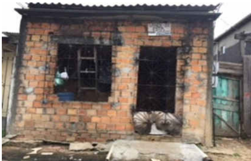
Foto 11 – Casa de madeira sendo remodelada para alvenaria (janeiro de 2018).
