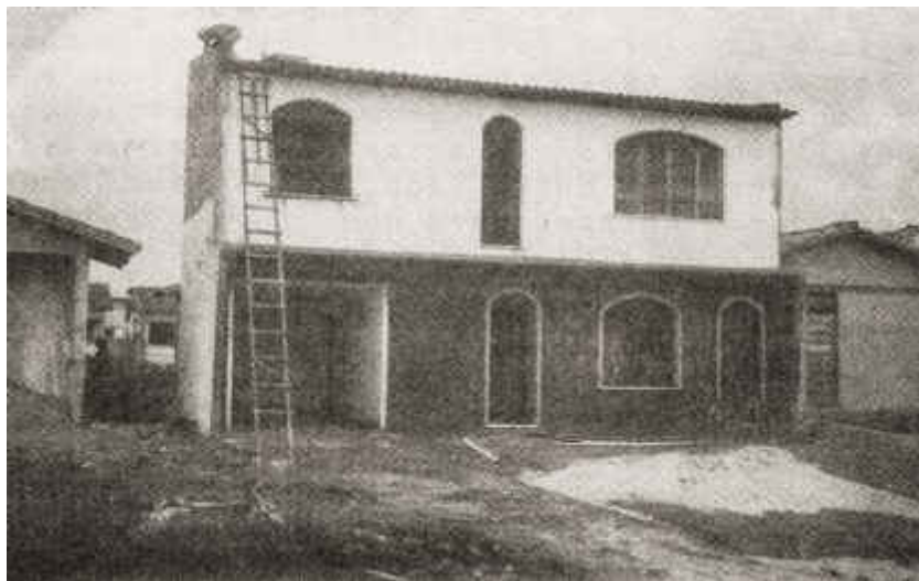
Foto 4 - Casa já vendida e com reforma quase concluída. Conjunto Providência. Agosto/1980
