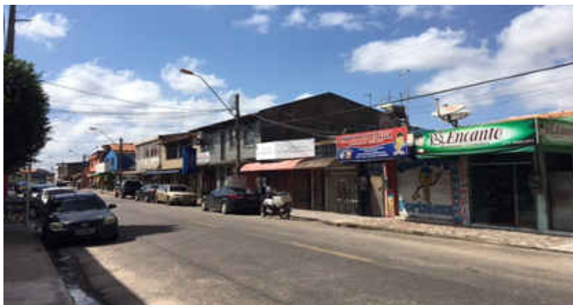
Foto 28 – Rua pavimentada do Condomínio Paraíso dos Pássaros.
