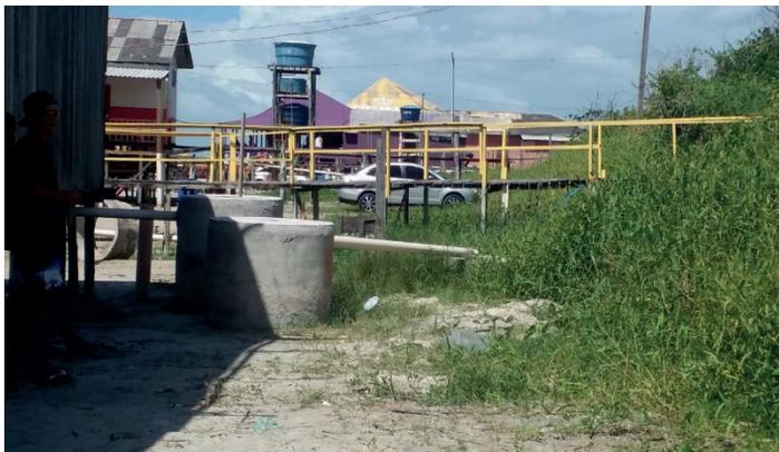
Figura 5: Sistema de fossas na faixa de praia e dunas. É possível observar, logo atrás, a instalação de poços artesanais.
