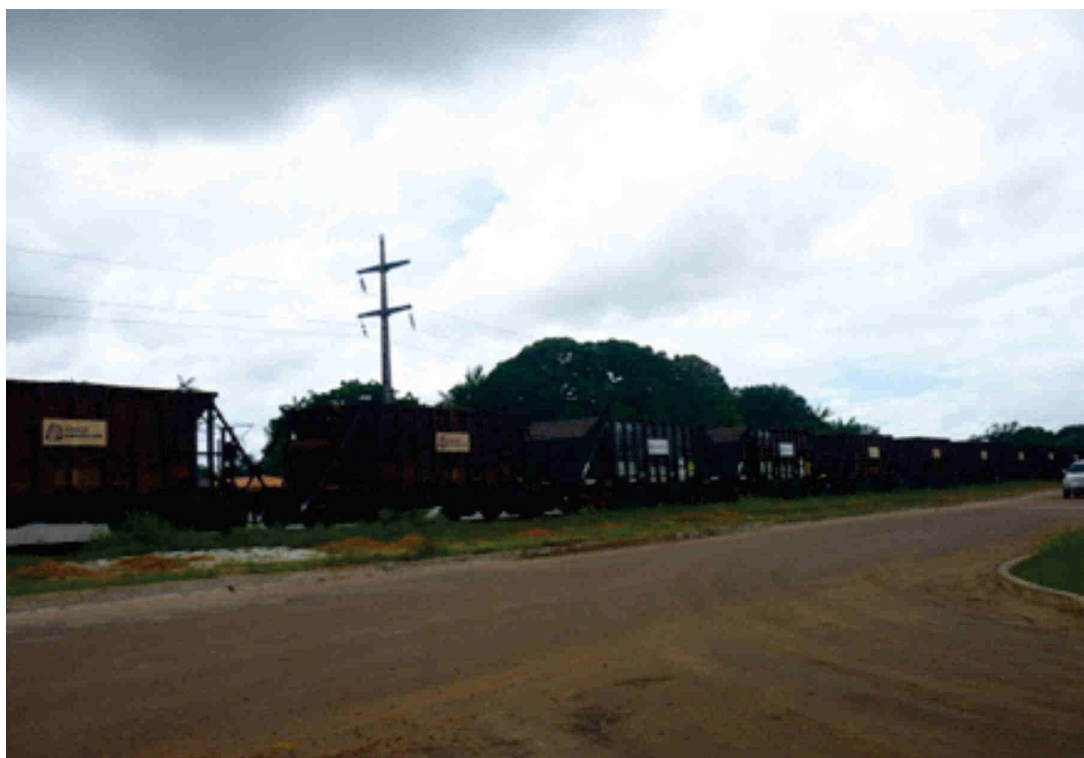
Fig. 7. TREM DE CARGA NA CIDADE DE PEDRA BRANCA DO AMAPARI - percorrendo trilhos em trecho instalado no centro urbano da cidade e transportando produtos das empresas mineradoras instaladas no município. Ana Regina Silva, 25/03/2011.
